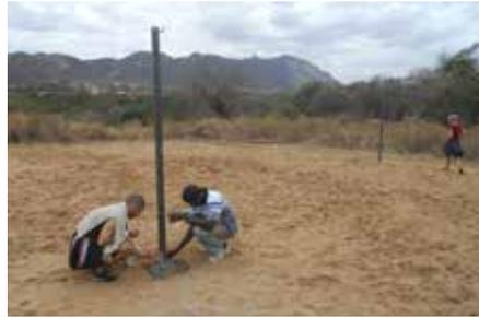
Bild 4a: Die Netzstangen werden einbetoniert.
